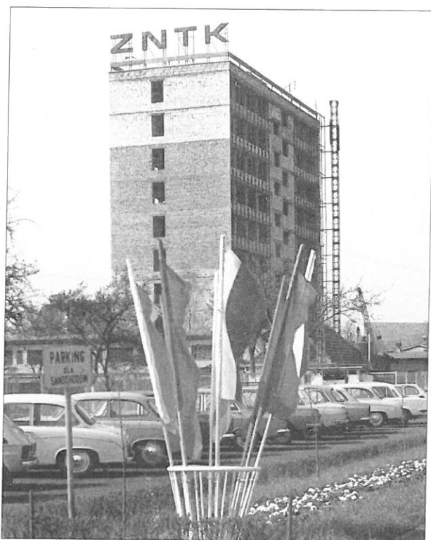
Ilustr. 17. Nowa siedziba zarządu zakładów i CBK-D w budowie, fot. z 1978 r.
